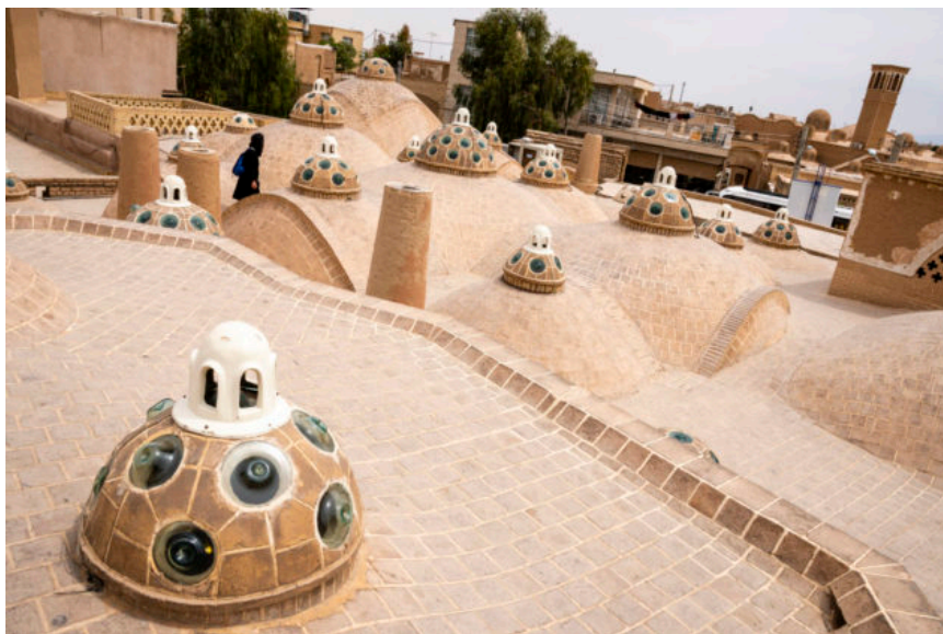
Střecha starých lázní
